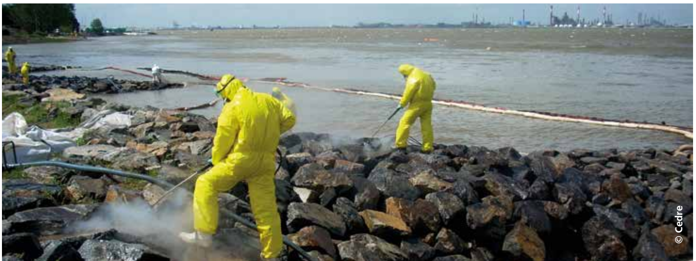
Chantier de nettoyage haute pression d'un enrochement
