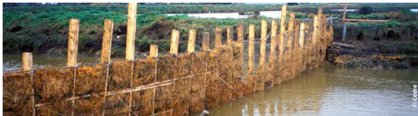
🚰 Barrage à façon, en paille
