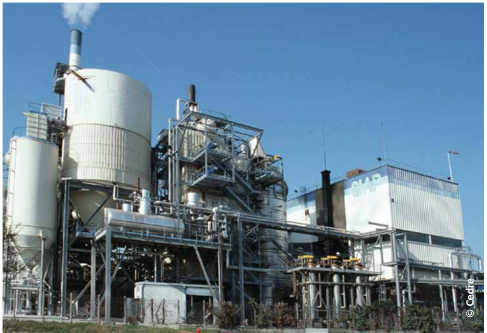
Centre de traitement spécifique des déchets industriels à Bassens
