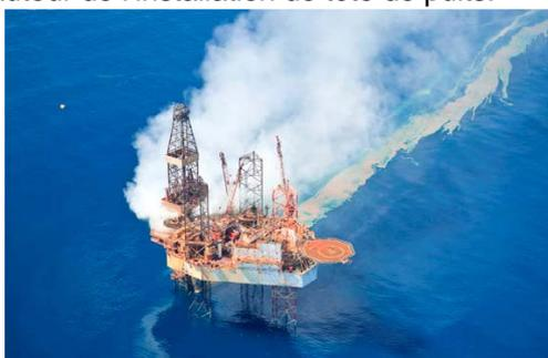
Eruption de brut et de condensats au niveau de l'installation de tête de puits (Source : AMSA)
