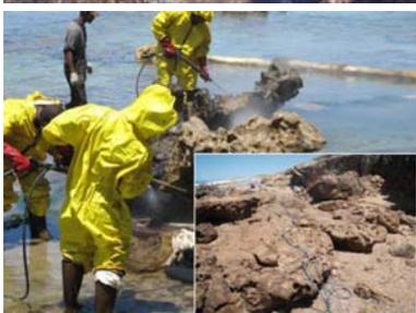
Collecte manuelle des plaques de fioul (haut) et nettoyage fin en haute pression de roches (bas)
