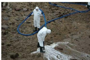
Brassage immergé (ou « flushing ») au moyen de lances impact. (Source : *Cedre*)
