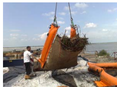
Grutage d'un chalut Thomsea utilisé à poste fixe sur un apponnement : collecte de roseaux pollués (Source : Thomsea)
