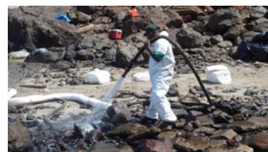
Rinçage des blocs souillés à l'aide de jet à basse pression (Source : Ocean Pollution Control S.A.)
