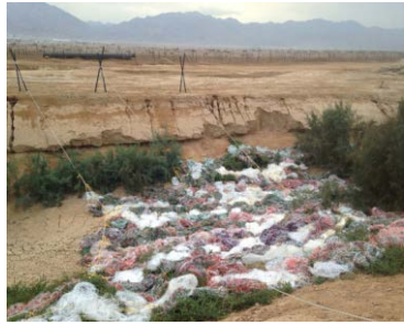
Pose d'absorbants en écheveaux dans le canal de Kinet (Gauche) ; Barrage mis en place le 9/12/14, au niveau du port d'Eilat (Golfe d'Aqaba) (droite) (source : MoEP)
