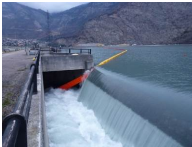
Test de tenue de barrage afin d'optimiser le débit d'exploitation : engagement du barrage dans le déversoir pour un débit de 80 m³/s (Source : Cedre)
