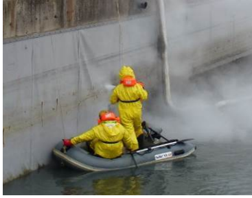
Rinçage en eau chaude basse pression de bâchages plastiques (gauche) ; Débris et fioul piégés dans le dégrilleur du barrage de Saint-Martin-de-la-Porte (droite) (Source : Cedre)
