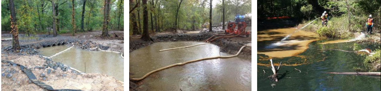
Confinement par barrages filtrants : talus busés (gauche) ; Camions à vide pour pompage des accumulations flottantes entre les talus busés (centre) ; Concentration, par jets d'eau, de la pollution flottante dans les aires de confinement (droite) (Source : USEPA)
