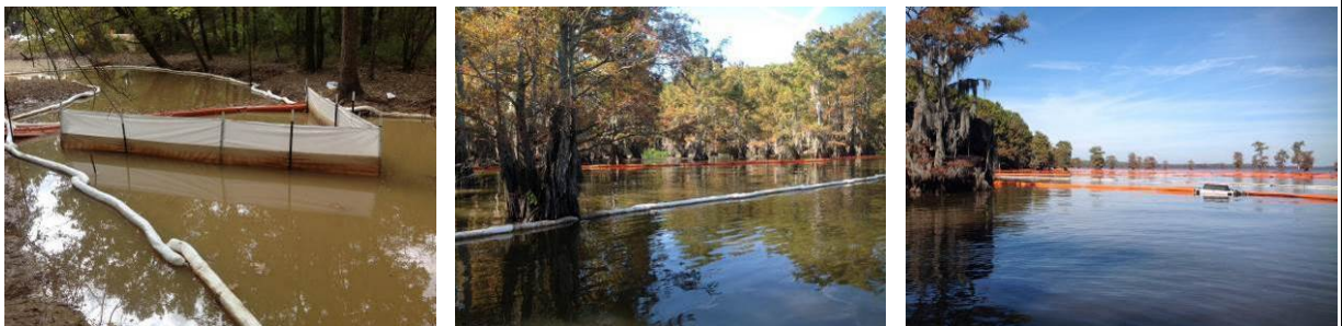
Confinement/protection : en cours d'eau, par barrages flottants, boudins absorbants et textiles oléophiles sur pieux (gauche) ; en zone inondée, par barrages flottants et boudins absorbants (centre) ; à l'exutoire du Bayou Tete dans le Lac Caddo, par rideaux de barrages flottants (avec récupérateur à tambour entre 2 sections du 1 er rideau) (droite) (Source : USEPA)
