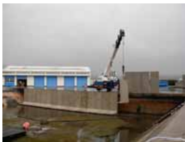
Gauche : pose de murs modulaires dans le bassin expérimental du Cedre ; Droite : préparation des tests / vue d'ensemble du dispositif (Source : Cedre)
