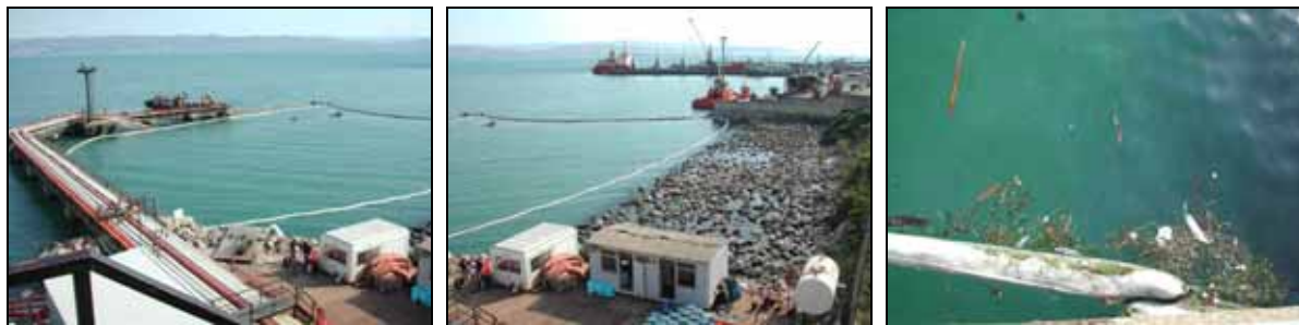
Vue de la jetée détruite et des barrages flottants et absorbants (Source : Cedre) Protection de la zone de blocs rocheux en arrière de la jetée (Source : Cedre) Irisations et débris accumulés contre barrages absorbants (Source : Cedre)
