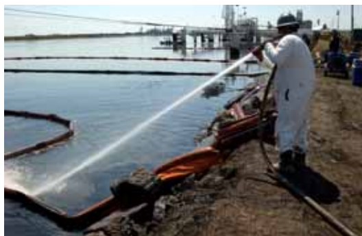
3 juin 2006 : Confinement (barrage) et récupération (récupérateur à tambour) des hydrocarbures sur les berges de la raffinerie Valero (Source : USCG)
