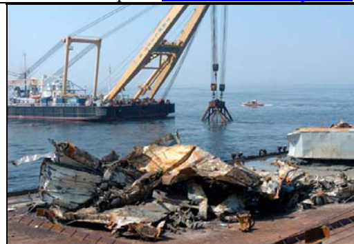
Relevage en cours par le grappin de la barge-grue Taklift 4
