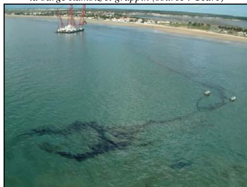
Vue aérienne du chantier et des opérations de dépollution (source : sécurité civile 17)
