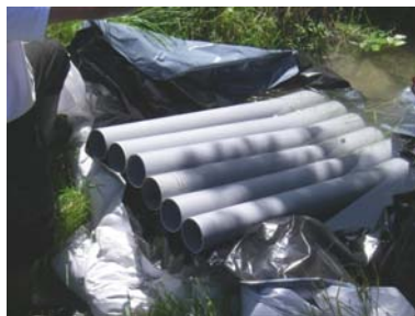
Confection du barrage busé (la bâche assure l'étanchéité de l'endiguement et la protection des berges) (Source : Cedre)
