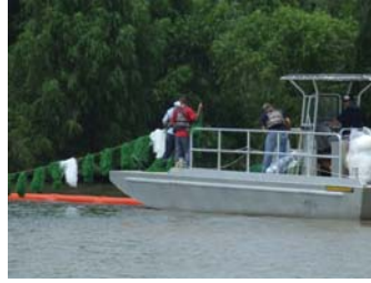
Sanctuaires faunistiques : pose de barrages absorbants (« pom-pom ») et flottants (Source : USFWS)
