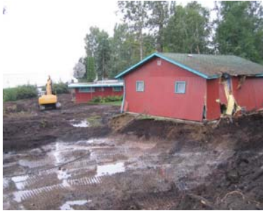
Enlèvement des sols contaminés près du site de l'accident
