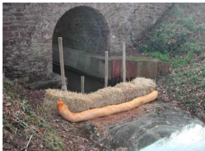
Barrage de fortune avec paille + boudins absorbants (ici en 1 er rideau au pont de la D33) (Source : Cedre)
