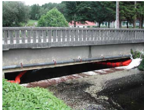
2 ème rideau : barrage + utilisation d'absorbants en feuille et en vrac (tourbe). Pas d'observation d'hydrocarbures à ce niveau (Source : Cedre).
