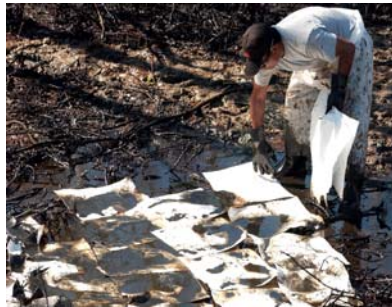
Récupération par absorbant sur le site de Bass Enterprises à Cox bay (source USCG)
