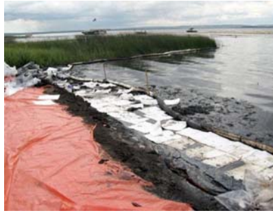
Absorbants (barrage et feuilles) et protection du sol par bâches
