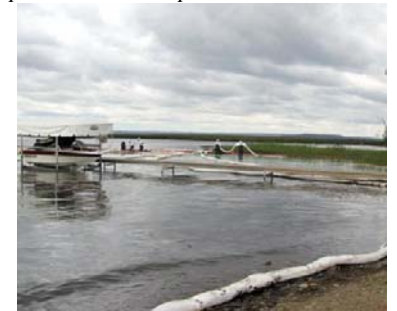
Protection de la végétation par barrages absorbants
