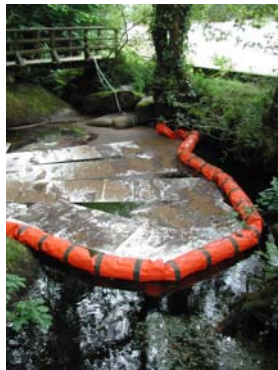
1 er rideau : barrage + utilisation d'absorbants en feuille et en vrac (tourbe) (Source : Cedre).
