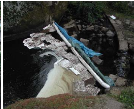
3 ème rideau : barrage de fortune (planches, bâches, boudins absorbants + absorbants en feuille et en vrac). Pas d'observation de fuel à ce niveau (Source : Cedre)
