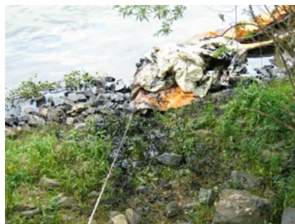
Utilisation de géotextile pour assurer l'étanchéité (source Cedre)
