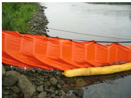
Utilisation d'un boudin absorbant pour assurer l'étanchéité (source Cedre)
