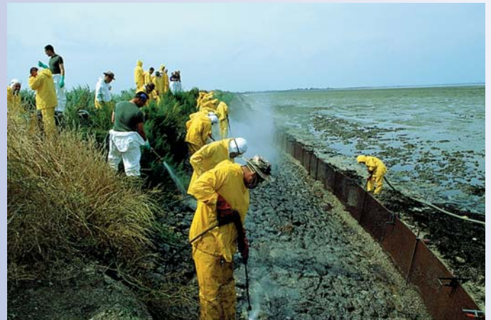
Premiers travaux en Vendée
