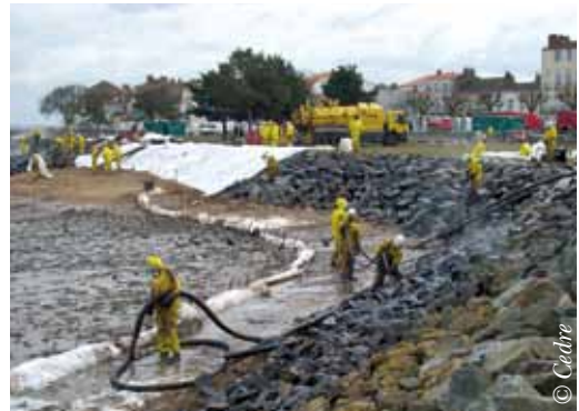
Chantier de nettoyage mécanique sur enrochement
