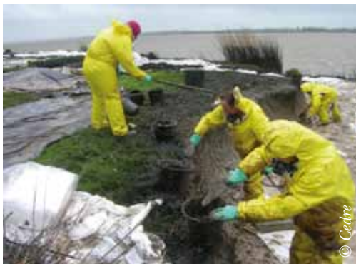
Chantier de nettoyage manuel
