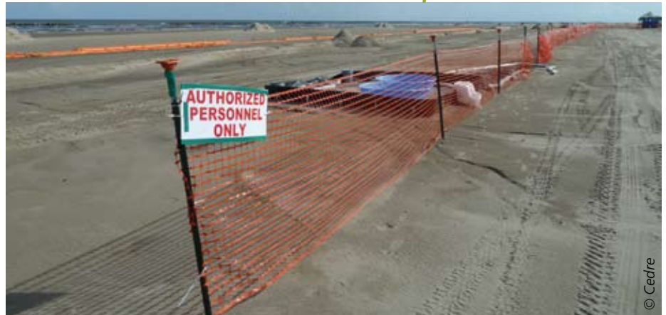
Mise en œuvre d'un chantier de lutte sur le littoral
