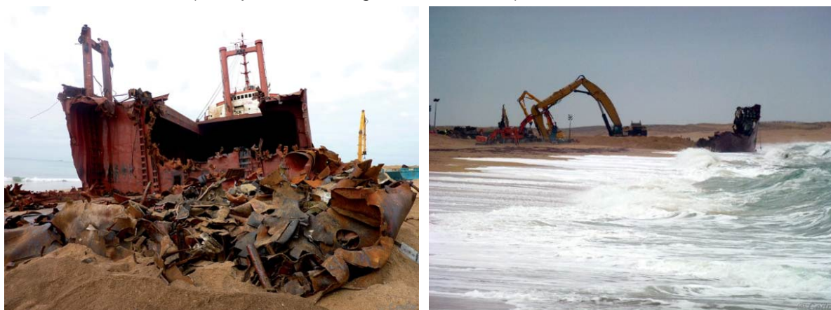
Janvier 2012 : vues du chantier de découpe et d'enlèvement de l'épave du TK Bremen (Source : Cedre)
