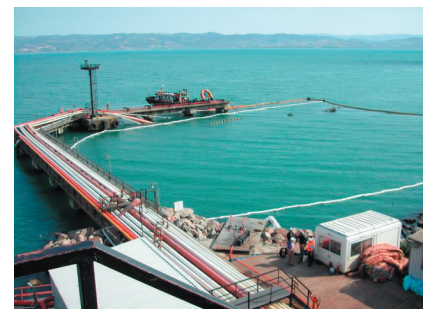
Le terminal de Gebze
