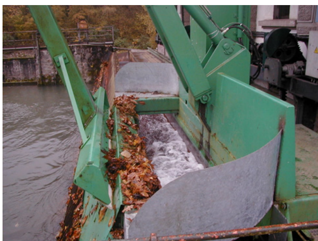
Photo 4 : Dégrilleur de Peyrouse (source : Institution Adour)
