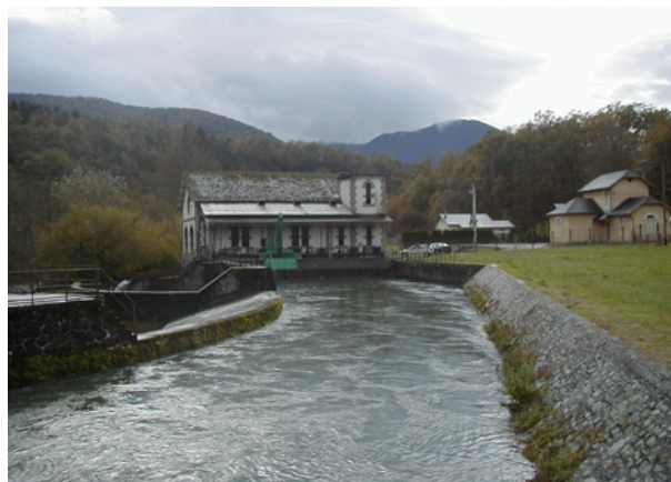
Photo 3 : Centrale de Peyrouse ( source : Institution Adour)
