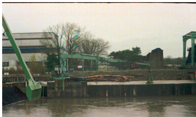
photo 1 : Dégrilleur (source : Institution Adour)
