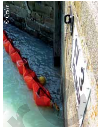
Câble tendu entre deux organeaux verticaux
