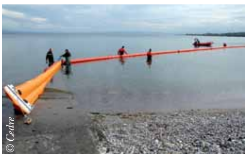
© Cedre Déploiement d'un barrage flottant échouable à partir d'une cale
