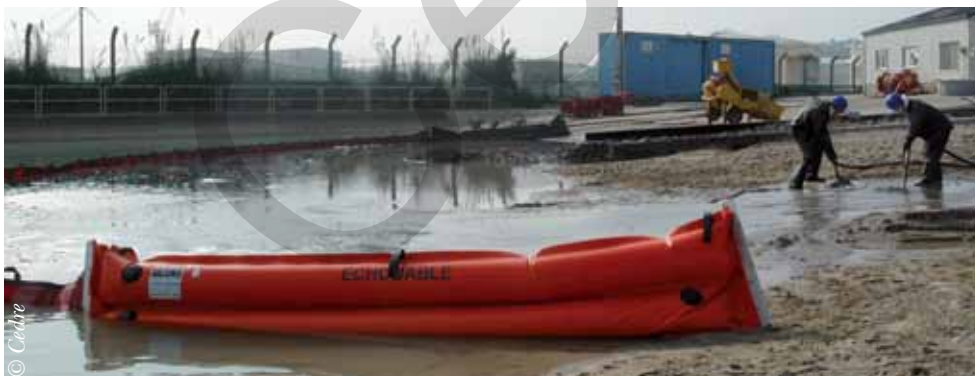
© Cedre Vue générale d'un chantier de nettoyage et d'un tronçon de barrage échouable servant à confiner les effluents pollués
