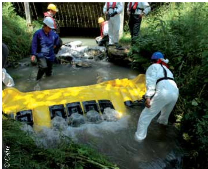
Mise en place d'un barrage anti-inondation
