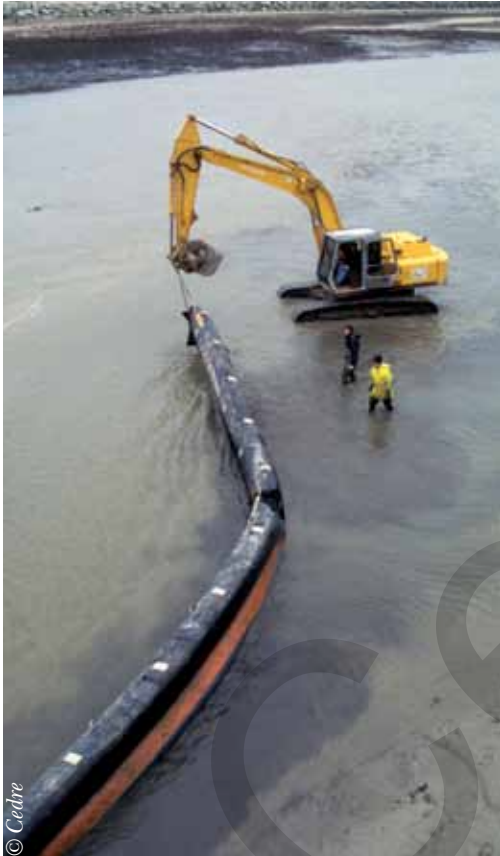
© Cedre Déploiement de barrage avec engin de travaux publics
