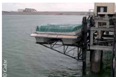
Ponton antipollution sur ascenseur
