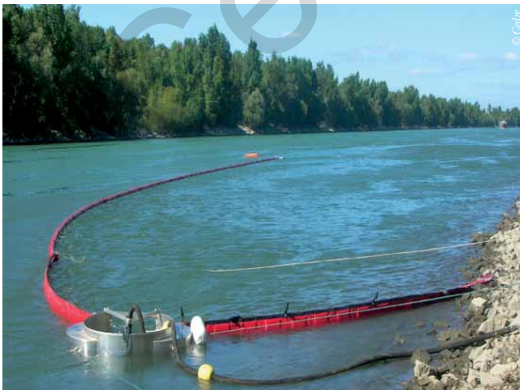
Déploiement d'un barrage à l'aide d'un paravane et système de récupération associé
