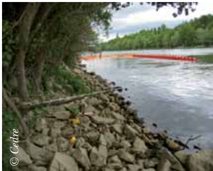
Barrage déviateur, amarré à un tronc d'arbre
