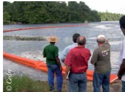
Déploiement d'un linéaire de barrage gonflable sur une rivière
