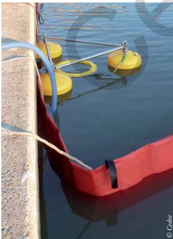
Cordage lesté pour plaquer le barrage contre un quai
