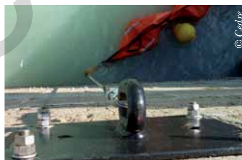
Câble tendu entre deux organeaux verticaux
