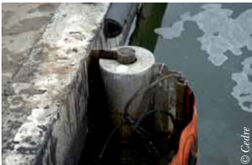
Flotteur cylindrique coulissant sur jonc fixe
