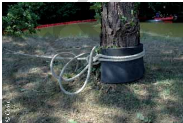
Ancrage sur bollard (en haut) Ancrage sur tronc d'arbre (en bas)
