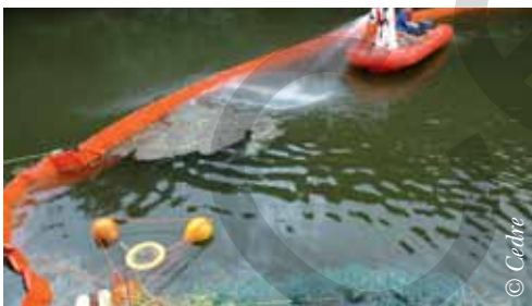
Mise à l'eau, utilisation et repli d'un barrage en rivière
