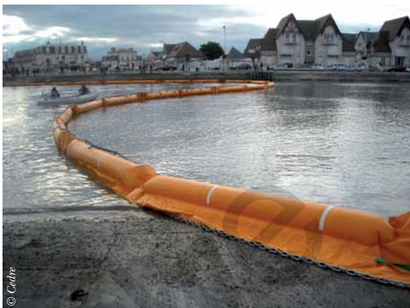
Déploiement d'un barrage rideau gonflable
