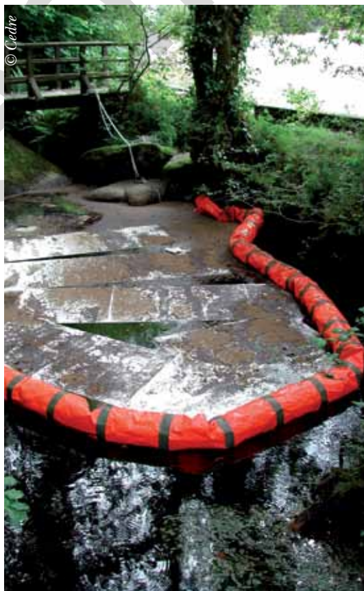
Piégeage d'hydrocarbures à l'aide d'un barrage et d'absorbants
