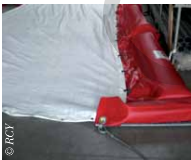
Barrage de travaux maritimes : vue de la jupe en géotextile
