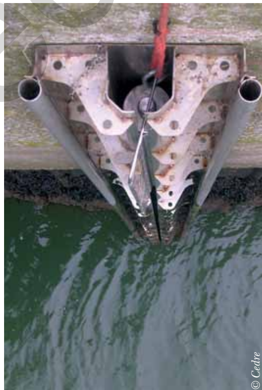
Tube cylindrique coulissant à l'intérieur d'une glissière fixe
