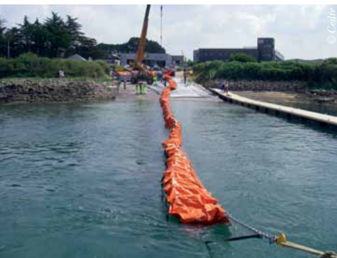
Mise à l'eau d'un barrage rideau à pain de mousse non compartimenté
