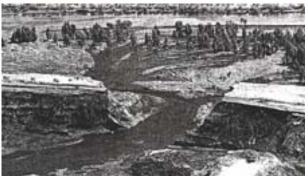
La digue après la rupture
