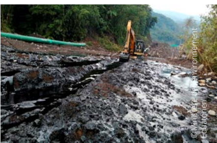
^ Creusement, par engins lourds, de fosses (gauche) et de tranchées (centre) de drainage pour limiter en urgence l'extension de la pollution à partir de la brèche du pipeline ; édification de talus de terre au niveau d'un écoulement dans la rivière Coca (droite)
