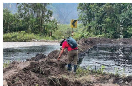
^ Creusement, par engins lourds, de fosses (gauche) et de tranchées (centre) de drainage pour limiter en urgence l'extension de la pollution à partir de la brèche du pipeline ; édification de talus de terre au niveau d'un écoulement dans la rivière Coca (droite)
