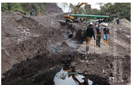
^ Creusement, par engins lourds, de fosses (gauche) et de tranchées (centre) de drainage pour limiter en urgence l'extension de la pollution à partir de la brèche du pipeline ; édification de talus de terre au niveau d'un écoulement dans la rivière Coca (droite)
