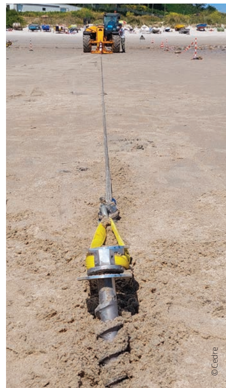
△ Arrachement d'une ancre à vis amarée dans le sable
