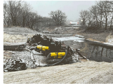
05/01/2023 : dérivation de Mill Creek (pompage en amont du site de l'accident, et rejet en aval) (Source : US EPA)
