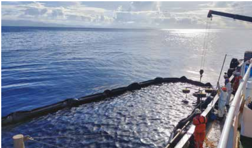
Mise à l'eau d'un récupérateur dans un barrage de confinement en mer - Philippines
