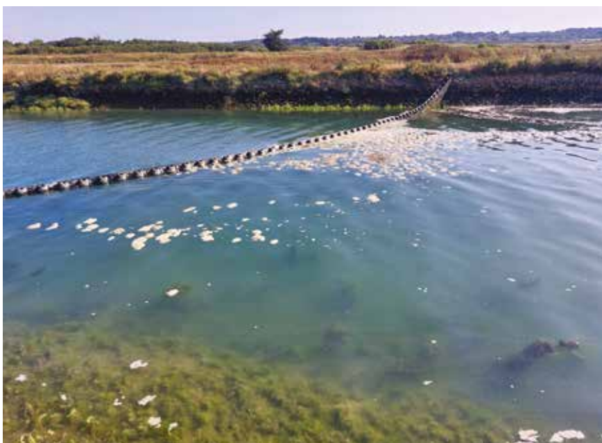
Mise en œuvre d'un barrage permanent avec filet dans un étier des marais salants de Guérande, Loire Atlantique (44)
