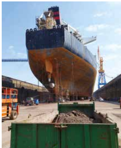
Intervention dans une forme de radoub Brest (29)
