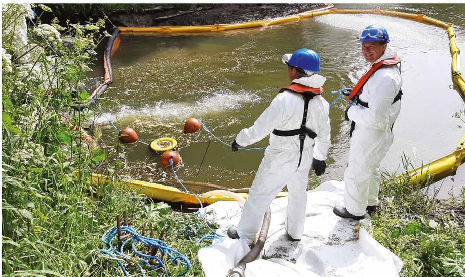
▲ Déploiement de barrage de protection dans le cadre d'un exercice pratique en eaux intérieures
