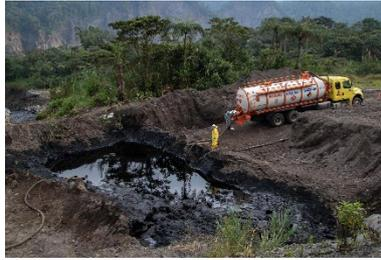
Confinement/collecte, par boudins absorbants, du pétrole brut dans des drains d'écoulement secondaires le long du ravin (gauche) ; pompage (camion à vide) au niveau d'un point/fosse de collecte (droite) (source : DR/Agencia Ecologista de Información)
