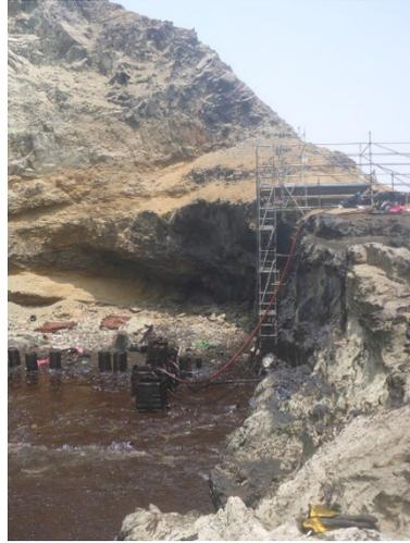
28/01/2022, Site de Cavelo : exemple d'aménagement des accès (ici, par échafaudages) à un chantier en fond de crique encaissée (source : Cedre)
