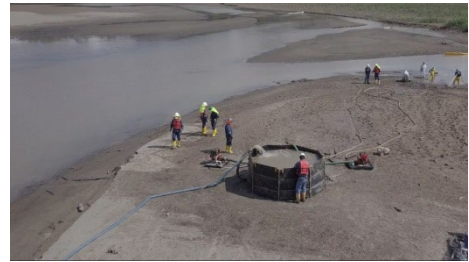
Bac de décantation/stockage temporaire d'eaux polluées sur berges (source : Lamor/Corena)
