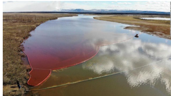
Chantier de déploiement/ancrage de barrages sur berges ; Dispositif de confinement et de protection des berges (barrages flottants, boudins absorbants) sur la rivière Ambarnaya (Source : DR/Russia Marine Rescue Service-Morspas)
