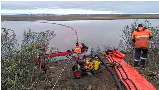
Chantier de déploiement/ancrage de barrages sur berges ; Dispositif de confinement et de protection des berges (barrages flottants, boudins absorbants) sur la rivière Ambarnaya (Source : DR/Russia Marine Rescue Service-Morspas)
