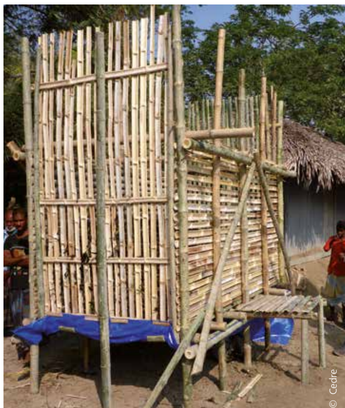
Cage de stockage/égouttage de déchets
