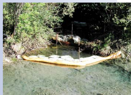
Barrage de planches en bois, paille et absorbants
