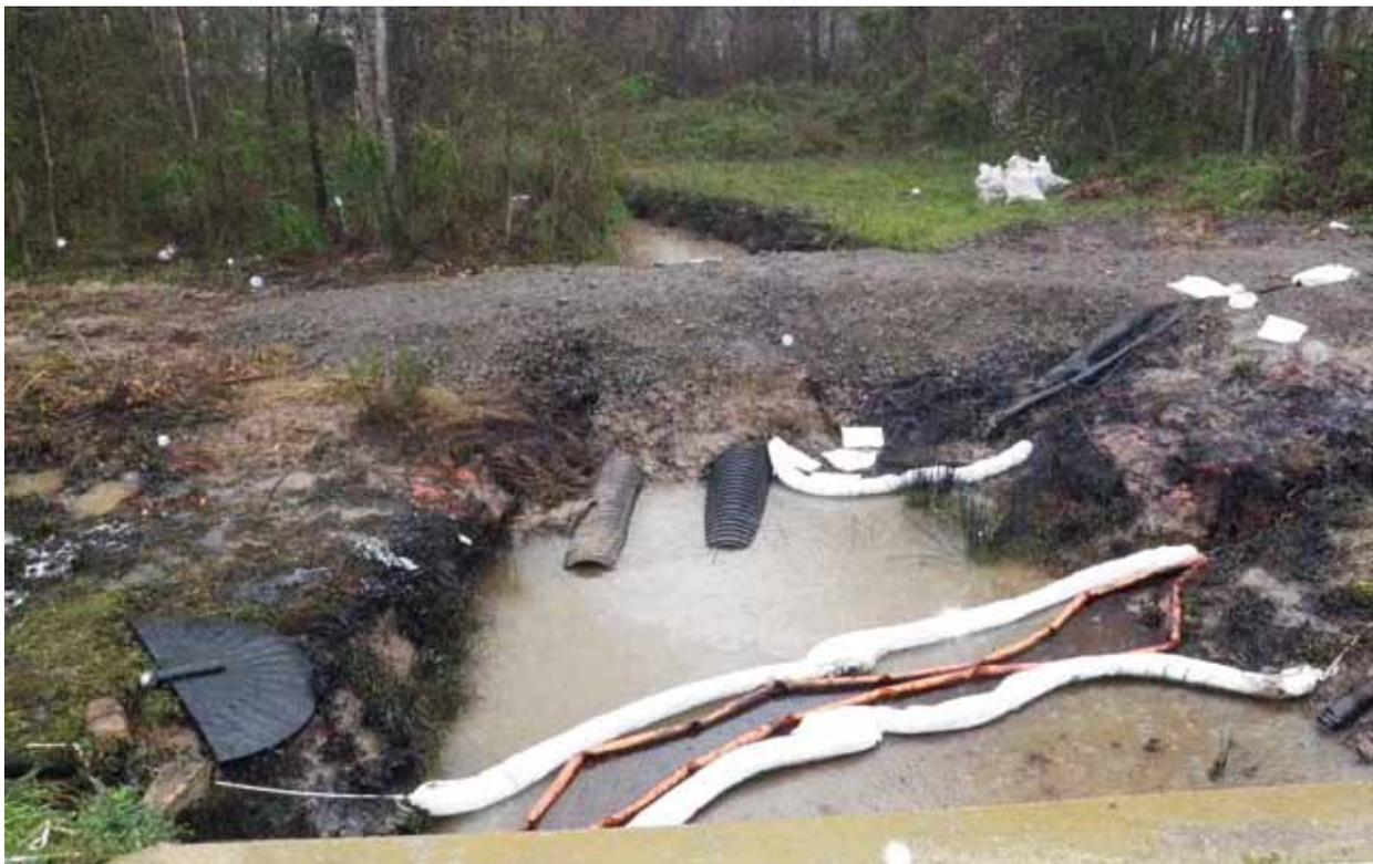
Dispositif filtrant (remblai busé) de confinement d'hydrocarbures en rivière, édifié en urgence sur un petit affluent du lac Conway (Arkansas, USA) (Source : US EPA)
