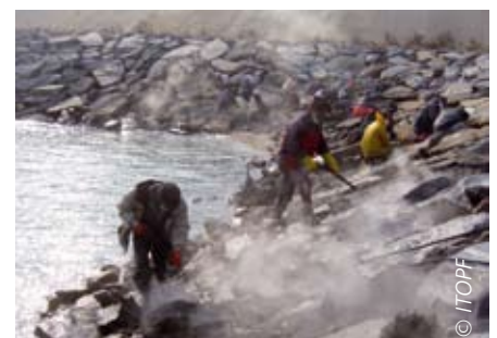
Nettoyage d'enrochements aux jets haute pression
