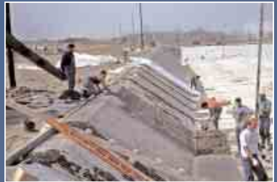
Bétonnage de la plage artificielle - 1994
