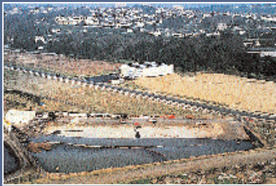
La zone d'expérimentations du Cedre avant travaux
