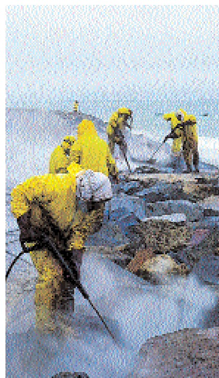
Nettoyage d'enrochements au nettoyeur haute-pression
