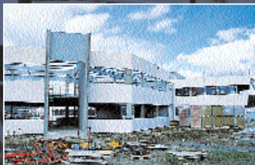
Construction du bâtiment - 1999
