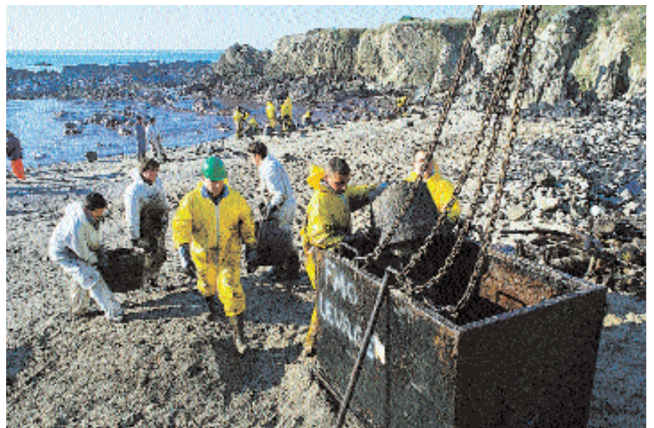
Evacuation des déchets dans une crique en pied de falaise (inaccessible aux engins lourds) : les seaux sont vidés dans une benne qui sera ensuite grutée.
