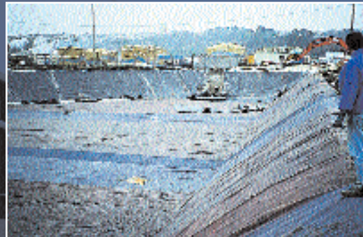
Bassin profond : terrassement et pose de la membrane - 1994
