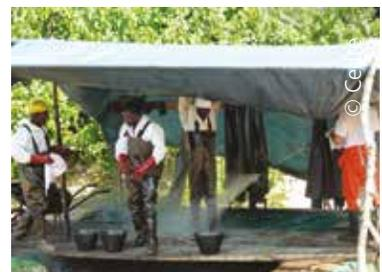
Lavage au nettoyeur haute pression avec température et pression limitées
