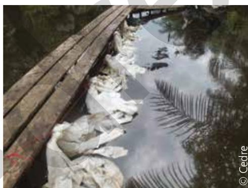
*Piégeage d'hydrocarbures en utilisant des combinaisons en polypropylène jetables usagées et fixées sous une passerelle*
