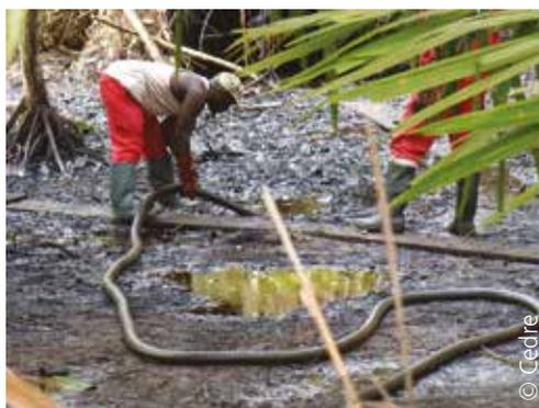
*Aspiration des poches d'hydrocarbures à l'aide d'un camion d'assainissement*
