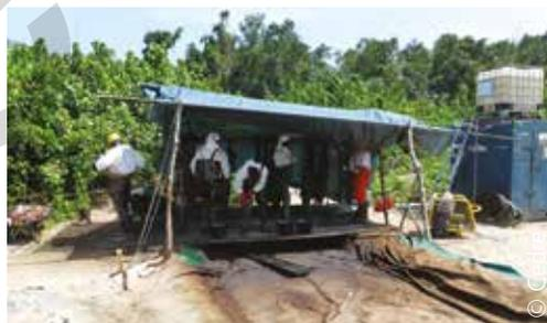
*Zone de décontamination équipée d'un nettoyeur à pression avec réserve d'eau (en hauteur sur le conteneur)*
