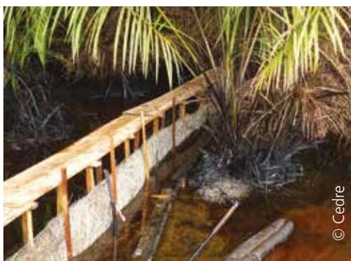
*Cartouche filtrante remplie de fibres de palmier installée sous une passerelle de cheminement*
