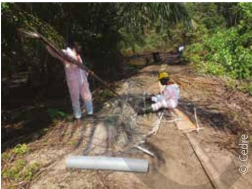
*Étalage de l'enveloppe au sol et garnissage du matériau de remplissage*
