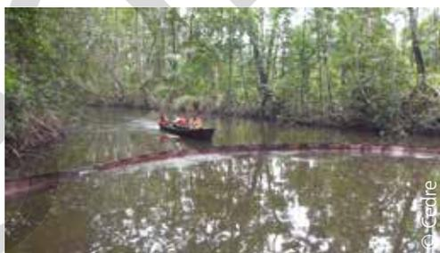
*Franchissement d'un barrage de type permanent par une pirogue, moteur relevé*
