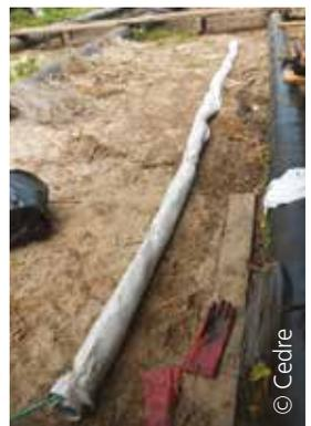
*Enroulement du géotextile sur les bouteilles*
