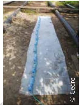
*Préparation des moyens nécessaires, étalement de la bande de géotextile au sol, pose du cordage puis des bouteilles*
