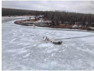
Confinement et récupération sur rivière gelée : découpage, dans la couche de glace, de fentes déviantrices de pollution flottante (Source : US EPA)
