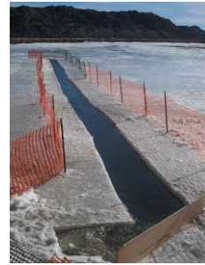
Confinement et récupération sur rivière gelée : découpage, dans la couche de glace, de fentes déviantrices de pollution flottante (Source : US EPA)
