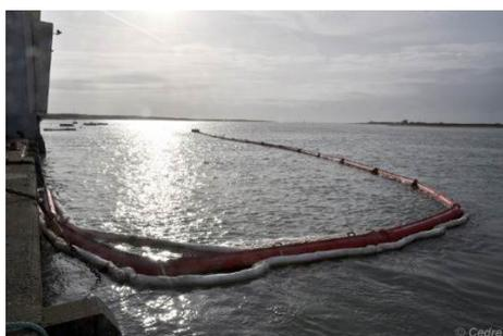
Dispositif de protection à Etel : barrage flottant en J + bouoindns absorbants (Source : Cedre)
