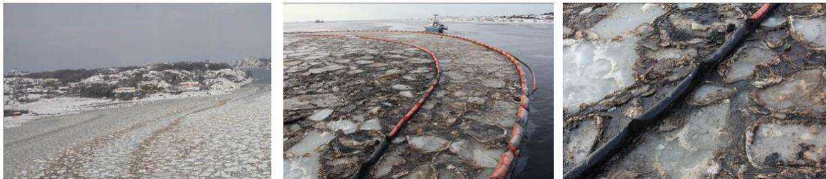
*Vue aérienne des traînées de fioul lourd déversé dans des eaux encombrées de glaces (gauche) ; Déploiement de doubles rideaux de barrages flottants (centre) ; « densité » des blocs de glace dans les poches de confinement (droite) (source : Kystverket)*
