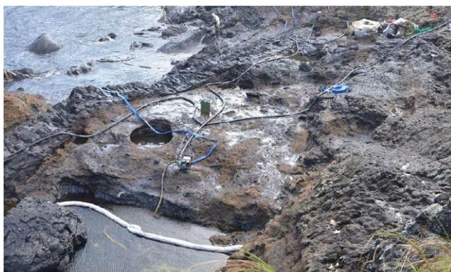
Chantier de nettoyage ; opérations de rinçage et confinement des effluents (Source : ITOPF)
