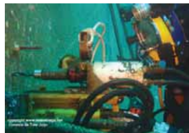
Perçage de la coque (Source : Sasemar-SeaSalvage)
