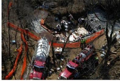
*Gauche : mise en œuvre de récupérateurs à tambours oléophiles Elastec ; Droite : Camions hydrocureurs (source : Ohio EPA).*
