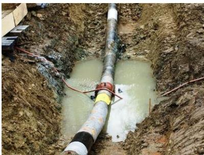
*Collier d'étanchéité (en rouge) sur la partie défailante, en attente d'un remplacement de la section (source : wwxu.org)*
