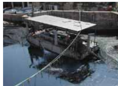
Petite barge de dragage PROMAR : aspiration de la nappe (après retrait des macrodéchets) et transfert en continu vers une capacité de stockage adaptée située en haut de falaise (Source : Cedre).
