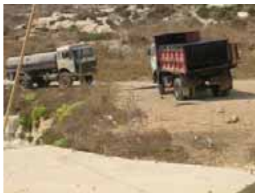
Transfert du fioul pompé : au choix, camion inadapté ou citerne en panne (Source : Cedre).
