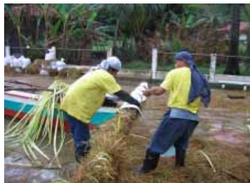
Confection de barrages de fortune (bambou et feuilles) (Source : ITOFF)
