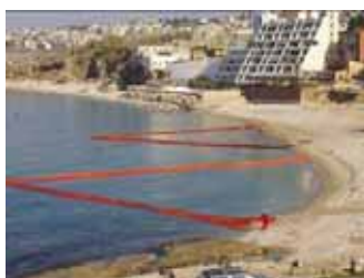
Dispositif de récupération du fioul libéré lors d'opérations de surfwashing menées par Seacor (Source : Seacor)
