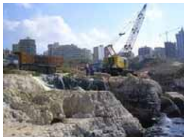
Essai de collecte à l'aide d'un crapaud : éclaboussures sur la falaise faute de moyens de protection adéquats disponibles (Source : Cedre).
