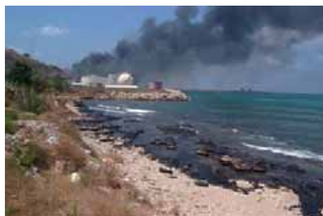
Plages de Jieh, au Nord de la centrale en feu. (Source : MoE)
