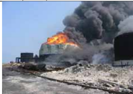
Le site de stockage de la centrale énergétique de Jieh, le 27 juillet (Source : MoE).
