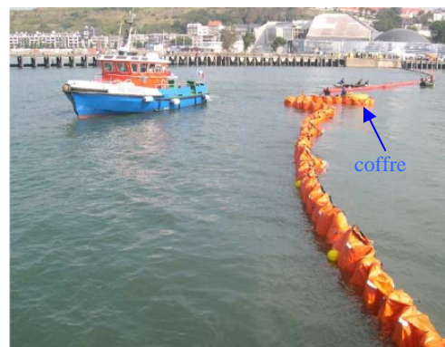
Fermeture de l'avant-port : amarrage des barrages et jonction au niveau du coffre flottant (source Cedre)
