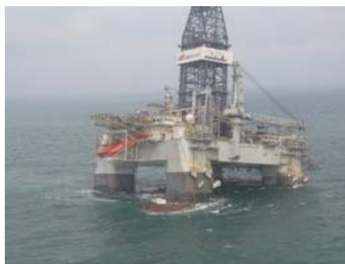
Vue aérienne de la plate-forme pétrolière DD1 (source Smit)
