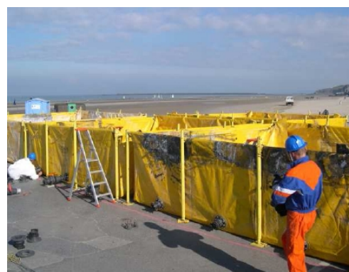
Bacs de stockage et de décantation TMB (source Cedre)
