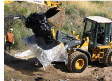
Récupération mécanique par pelle chenillée et tractopelle (noter le bâchage du godet pour limiter la contamination secondaire des engins) (source : EPA)
