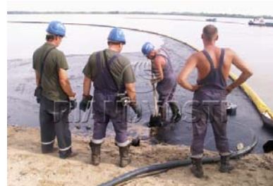
Confinement et récupération (écrémeurs) de fioul lourd (source : Ria Novosti)
