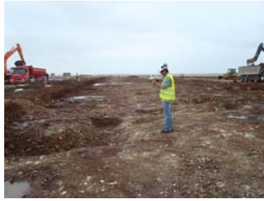
Décapage du sol jusqu'au toit du poudingue (source : Cedre).
