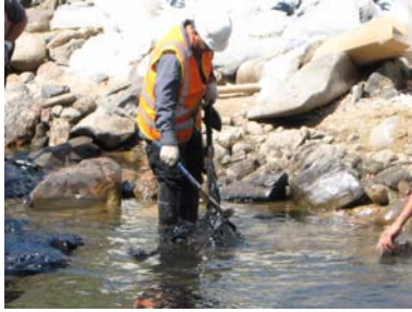
Découpage à la cisaille ( gauche ) ou à la hache ( milieu ) puis ramassage manuel des accumulations de bitume solidifié et coulé. Emploi de burins pneumatiques sur rochers secs ( droite ).
