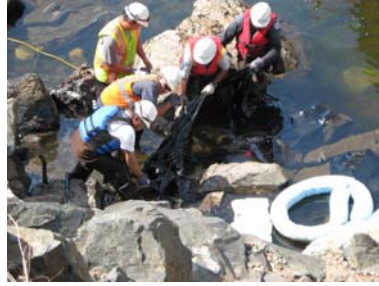
Découpage à la cisaille ( gauche ) ou à la hache ( milieu ) puis ramassage manuel des accumulations de bitume solidifié et coulé. Emploi de burins pneumatiques sur rochers secs ( droite ).
