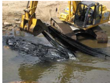
Récupération mécanique par pelle chenillée et tractopelle (noter le bâchage du godet pour limiter la contamination secondaire des engins) (source : EPA)
