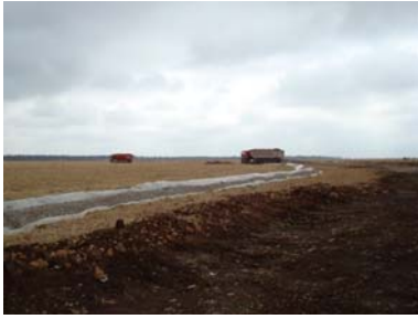
Merlon creusé en amont de la zone polluée (source : Cedre)
