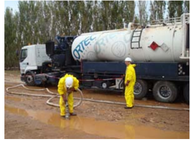
Pompage des irisations après un épisode pluvieux (source : Cedre)
