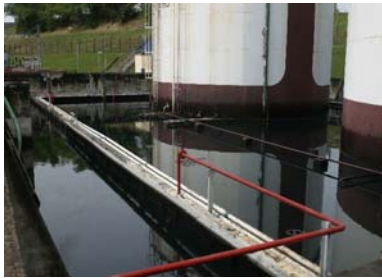
Cuvette de rétention de gasoil.
