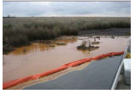
Confinement de nappes libres à proximité des rives (Source : NOAA)
