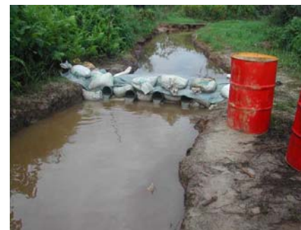
Vue d'un barrage busé (Source : Cedre)
