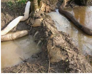
Barrage de fortune (remblai busé) et boudins absorbants (Source : Cedre).
