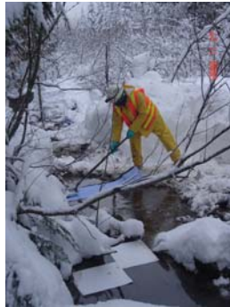
Pose de feuilles d'absorbants au niveau des suintements
