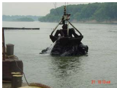
Récupération mécanique au moyen de godets des plus gros amas d'asphalte, semi solides (Source : USCG)
