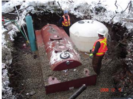
Installation en fond de tranchée d'un séparateur d'hydrocarbures (4m 3 ) + bac pour traitement de l'eau
