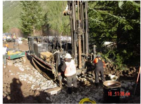
Mise en œuvre de matériel de forage pour le suivi de la pollution infiltrée (Source photos: Wash. State Dept. of Ecology)
