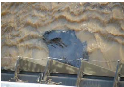
Vue depuis le tablier du pont : les écoulements d'asphalte coulent rapidement (Source : USCG)
