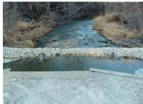
Edification d'un barrage filtrant en calcaire sur la Lime Creek en aval du point de déversement. (source : KDHE)
