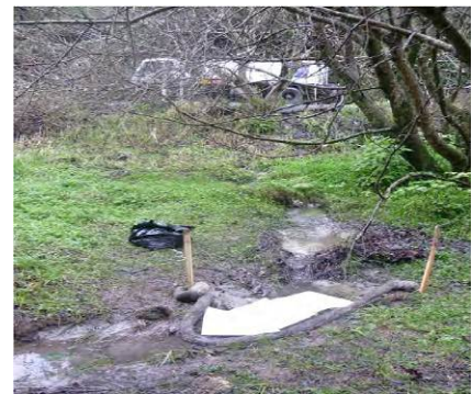
Pose d'absorbants au niveau du site de l'accident (source : Waikato Regional Council)
