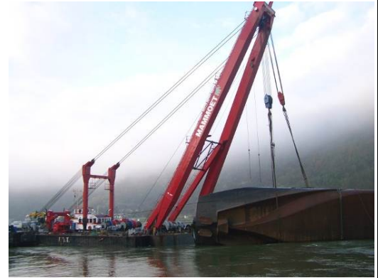
Sécurisation de la barge Waldhof au moyen de pontons grues durant les opérations de sauvetage (Source : Mammoet Salvage )
