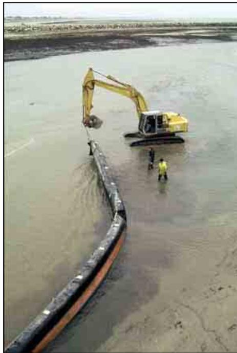
Déploiement de barrage en zone côtière
