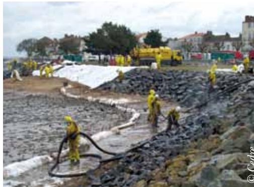
Chantier de nettoyage mécanique sur enrochement
