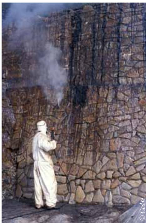
*Nettoyage haute pression d'un mur de soutènement par une société spécialisée*
