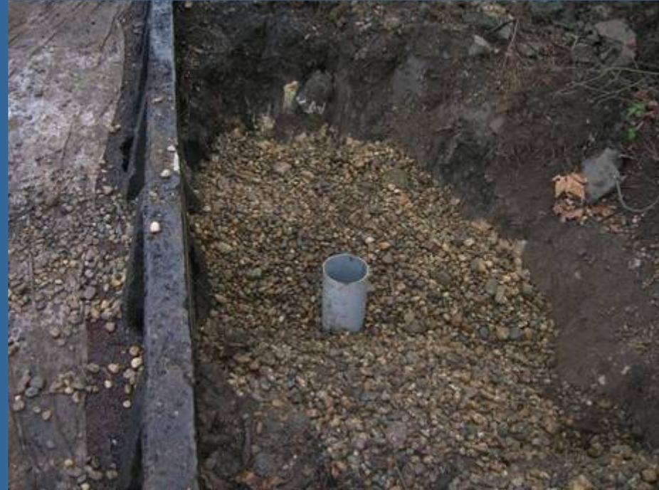
Création d'un drain vertical pour réaliser un test de purge du polluant imbibé dans le sol des berges (début le 20/01/2007)
