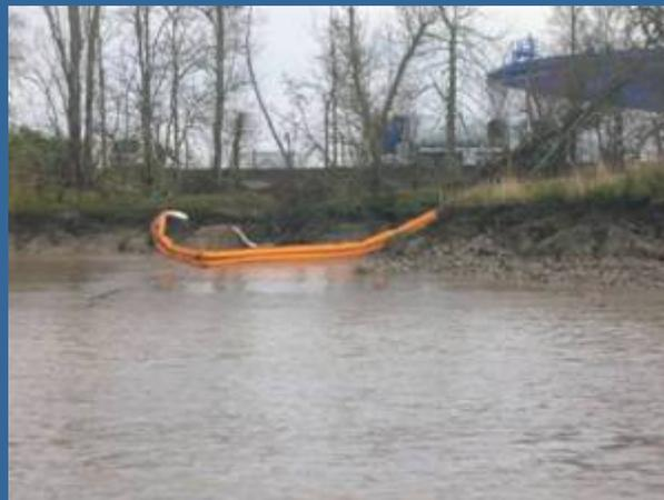
Installation d'un barrage échouable devant le principal écoulement (le 15/01/2007)
