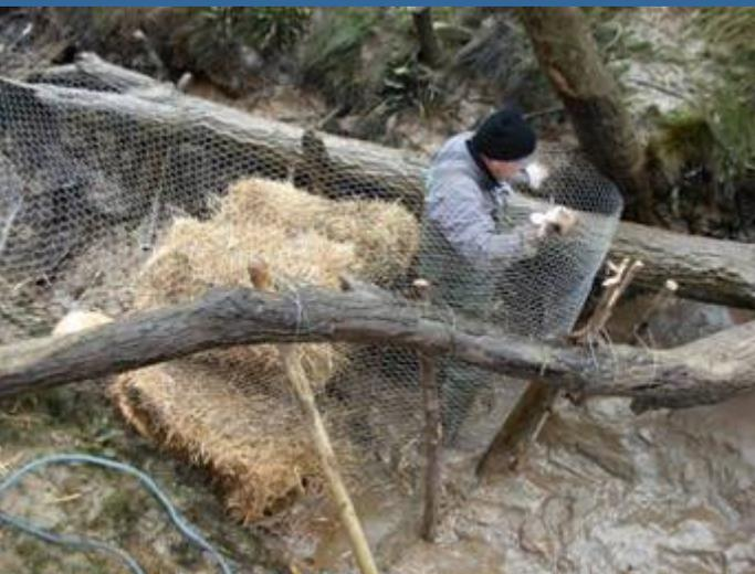
Mise en œuvre de barrages de fortune (paille + grillage + géotextile) pour renforcer le dispositif (début le 18/01/2007)
