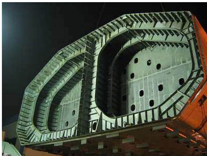
Citerne de type A - cloison transversale
