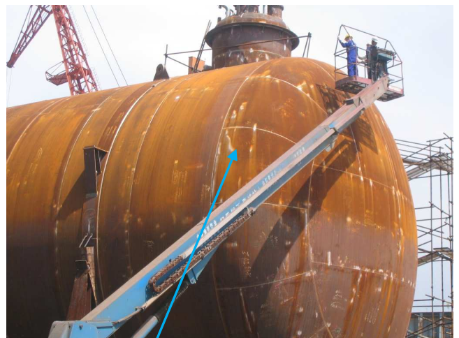
un seul dôme pour les tuyauteries gaz et liquide (ex : citerne pressurisée - L35m Ø12.4m)
