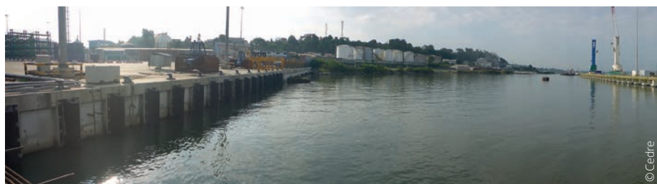
▲ Dépôt de la SGEPP à Owendo, Libreville - Gabon
